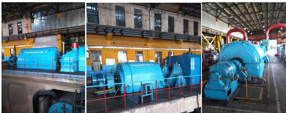
Зураг 9. Турбин генератор
